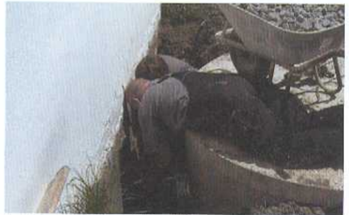
Auch der Solaranlagen-„Bauer“ (bitte auf den Namen achten) trifft die letzten Vorbereitungen am Belüftungsschacht.
