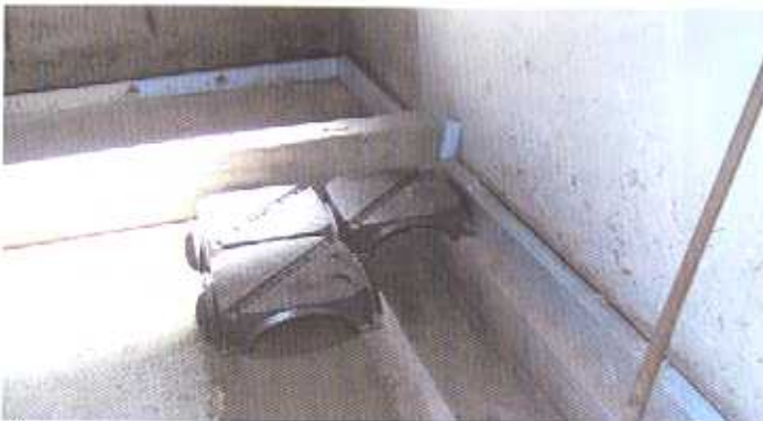
Über den Luftzuführschächten sieht man die ersten sog. Dalliformen, die die Hohlräume für die Hypokaustenheizung bilden.
