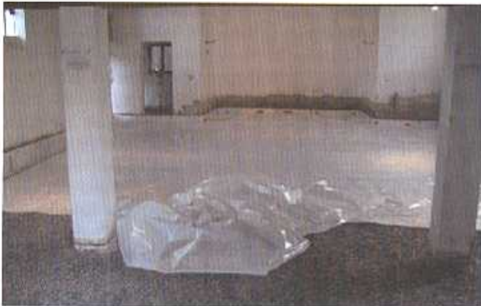
Auf das Wärmedämmungsgranulat wird eine kapillarbrechende Folie verlegt, um aufsteigende Feuchtigkeit zu unterbinden.
