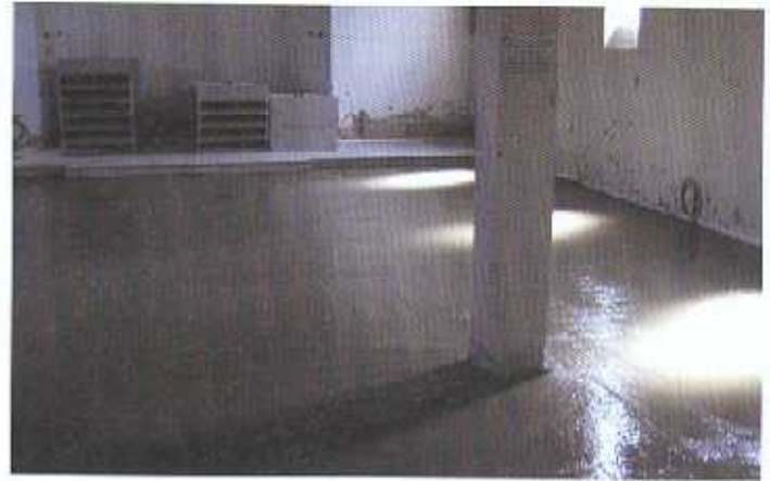
Nun ist die zweite Betonschicht über den Dalliformen aufgebracht.
